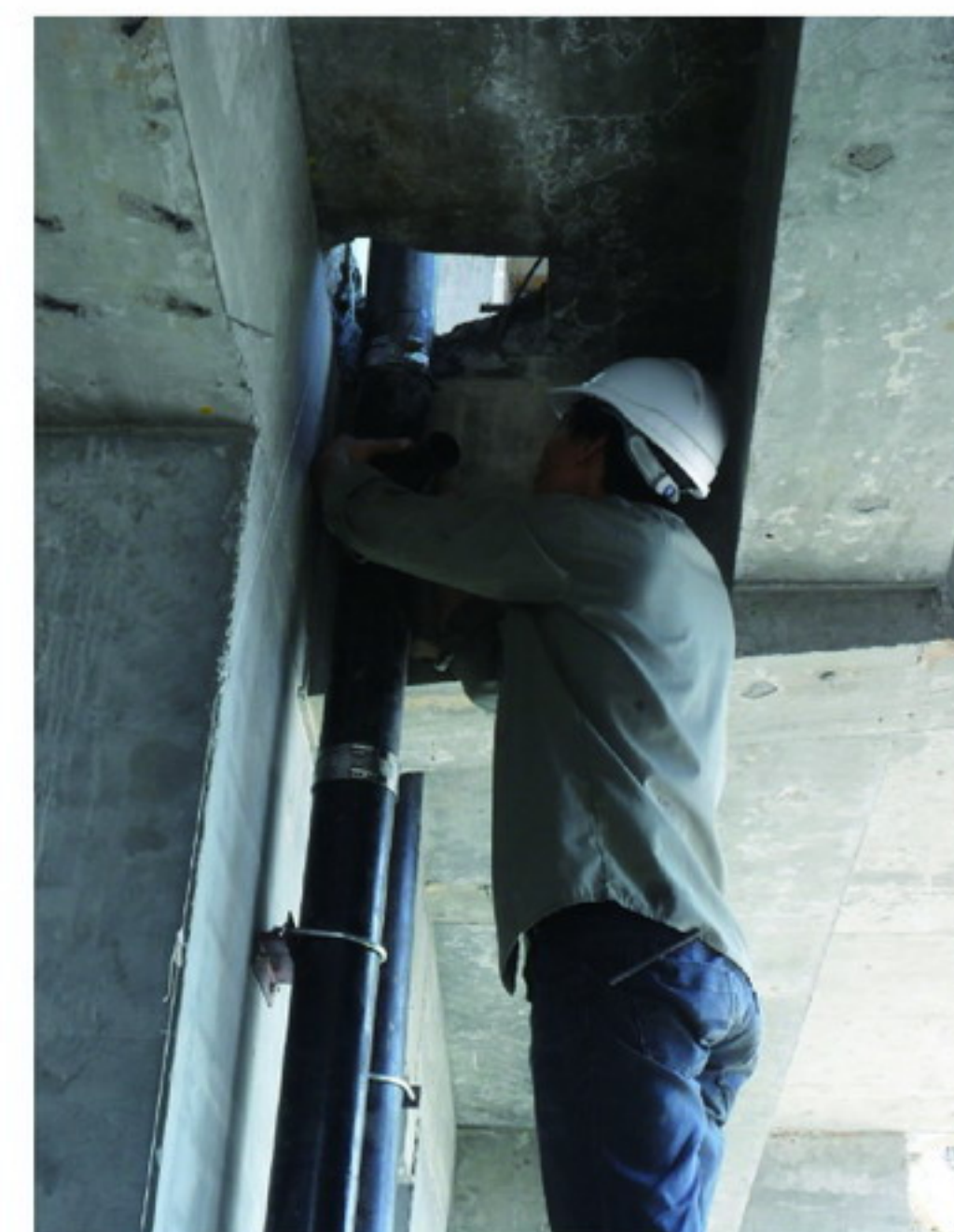
正在安装雨水管
