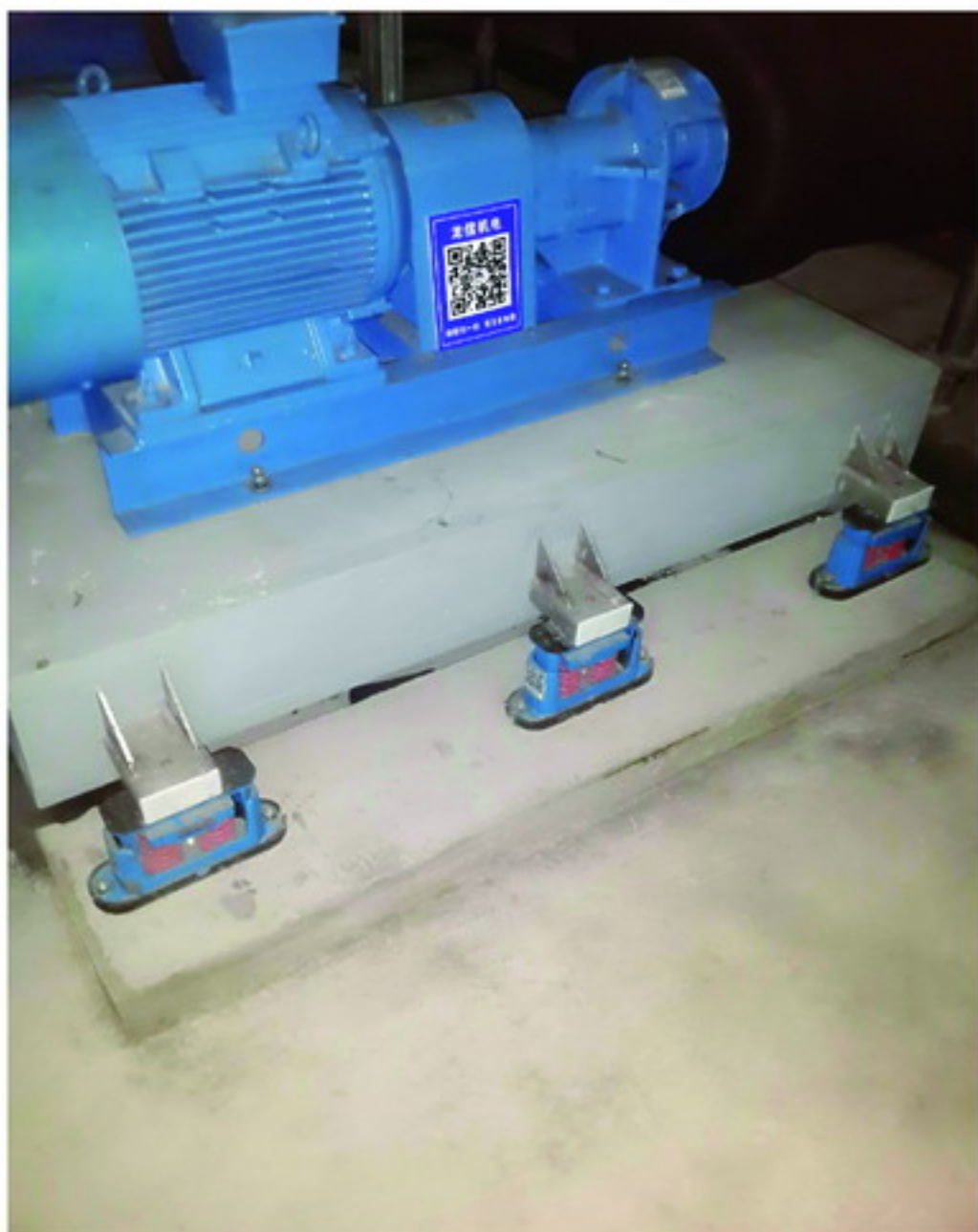
水泵钢弹簧减振器
