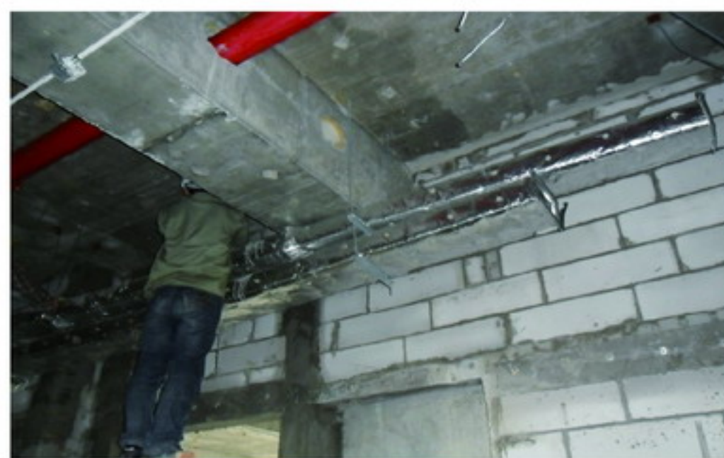
正在安装风管
