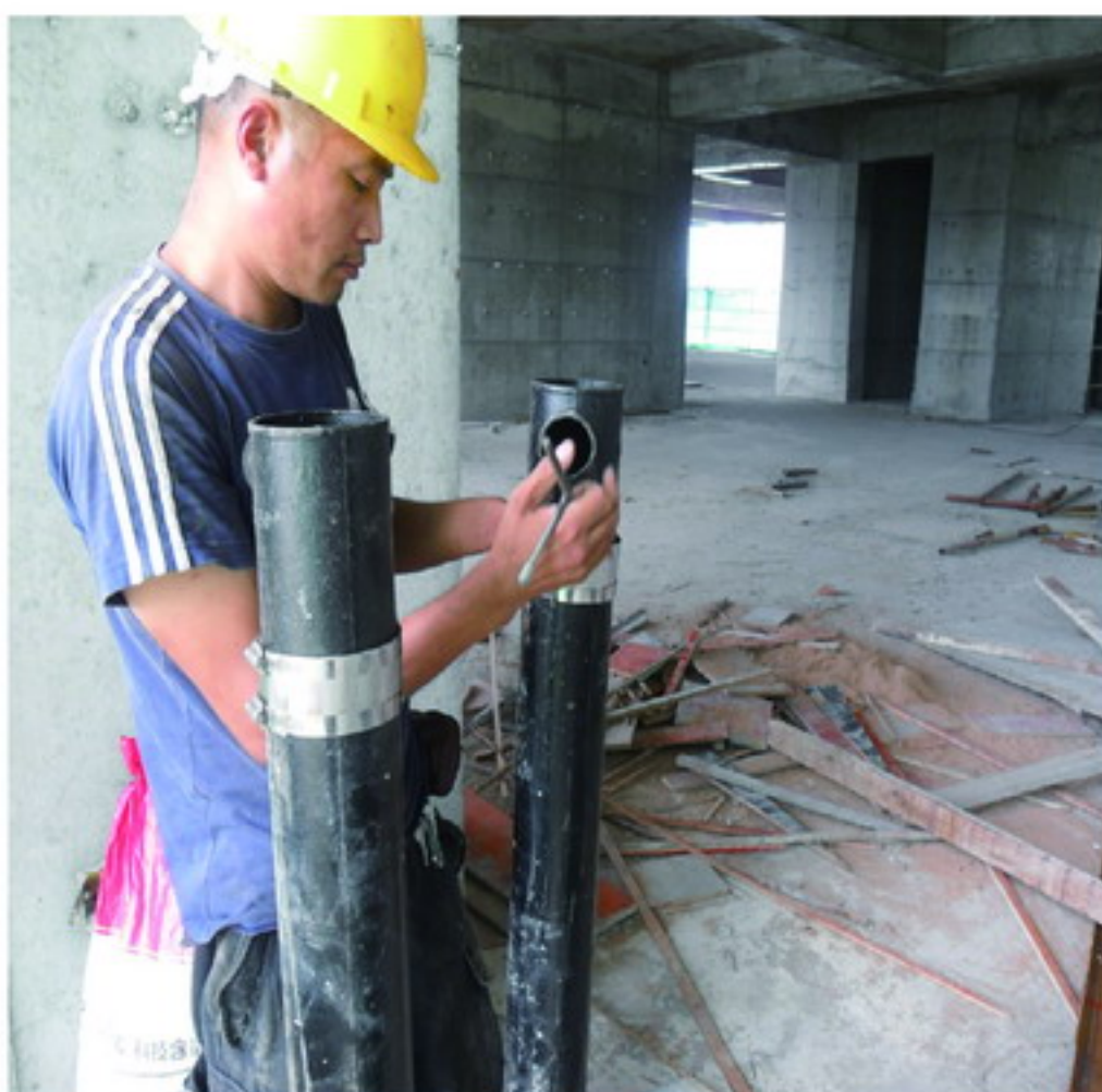
正在卡箍连接铸铁管
