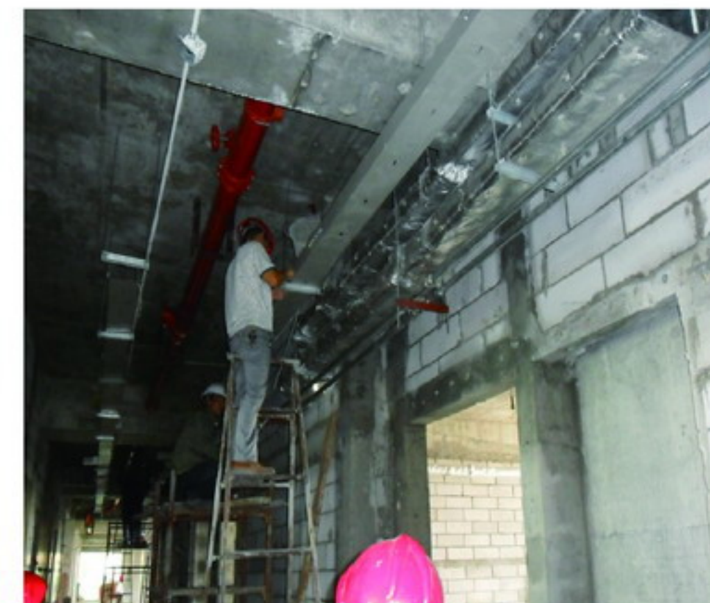
正在聆听施工员有关安装桥架的指导
