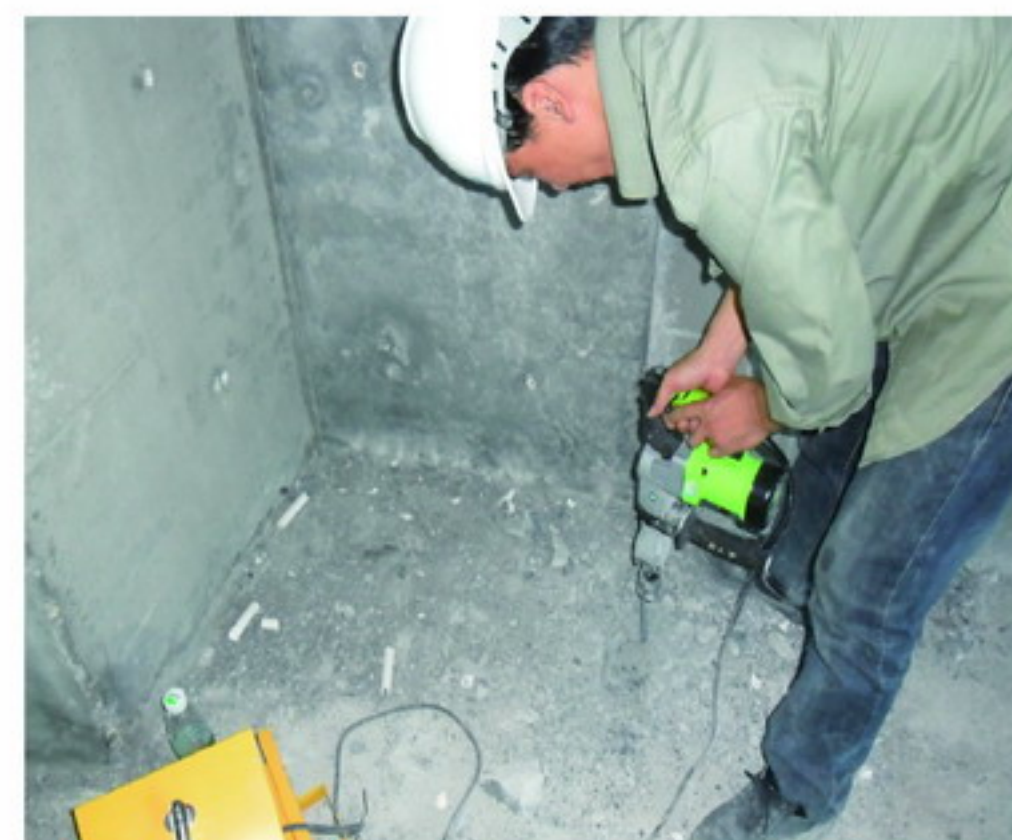
正在钻孔作业
